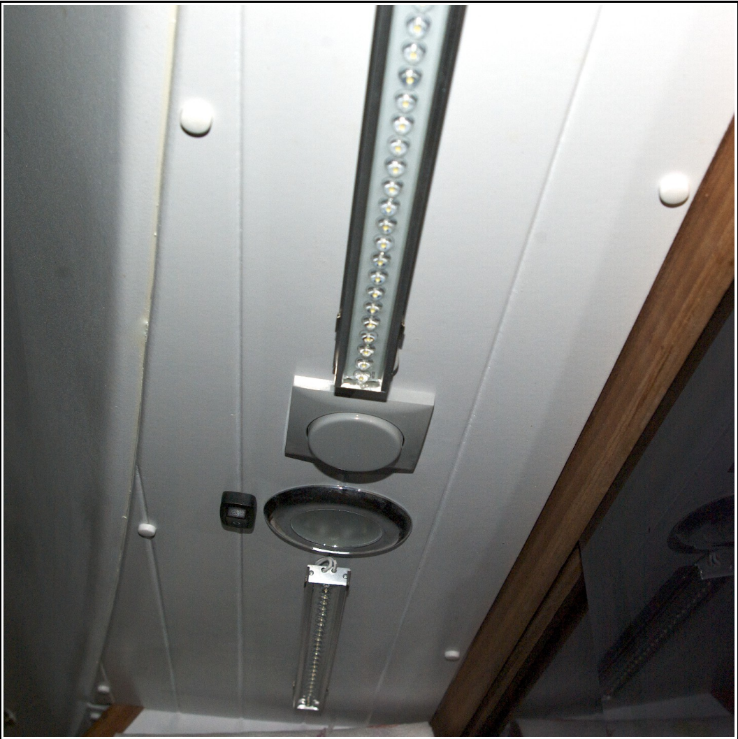
2011 -Amélioration de l'éclairage.
